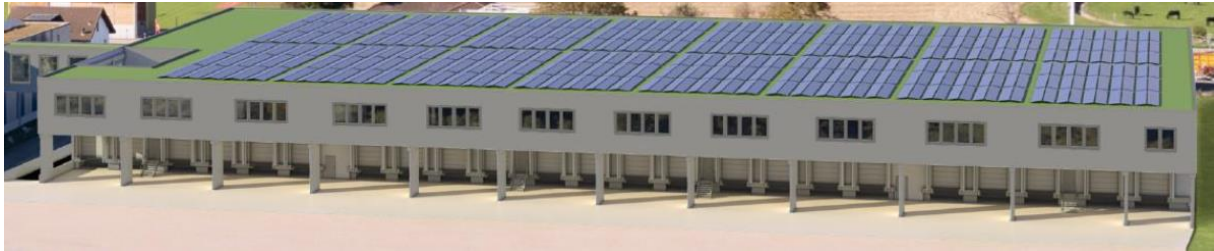
Abb. 9 Situation Baubereich F mit überdachter Rampenanlage
